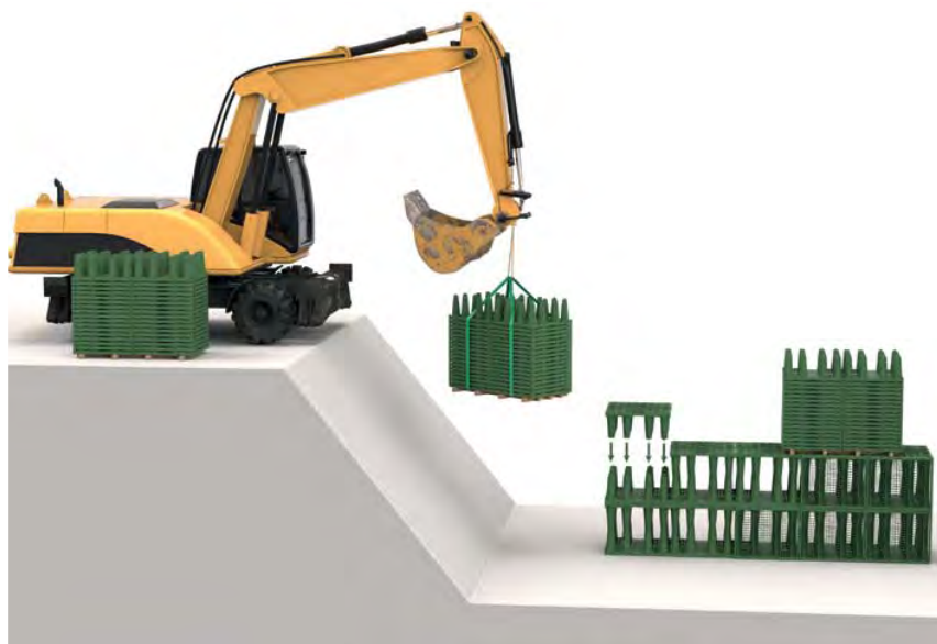
Montage dans la fouille
