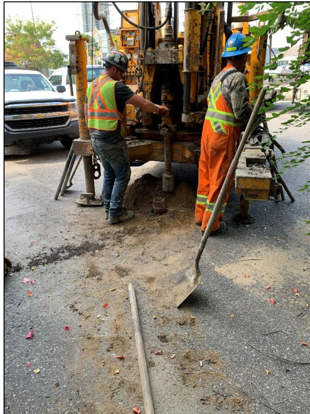
Réalisation du forage F-02
