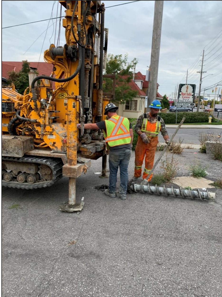
Réalisation du forage F-01
