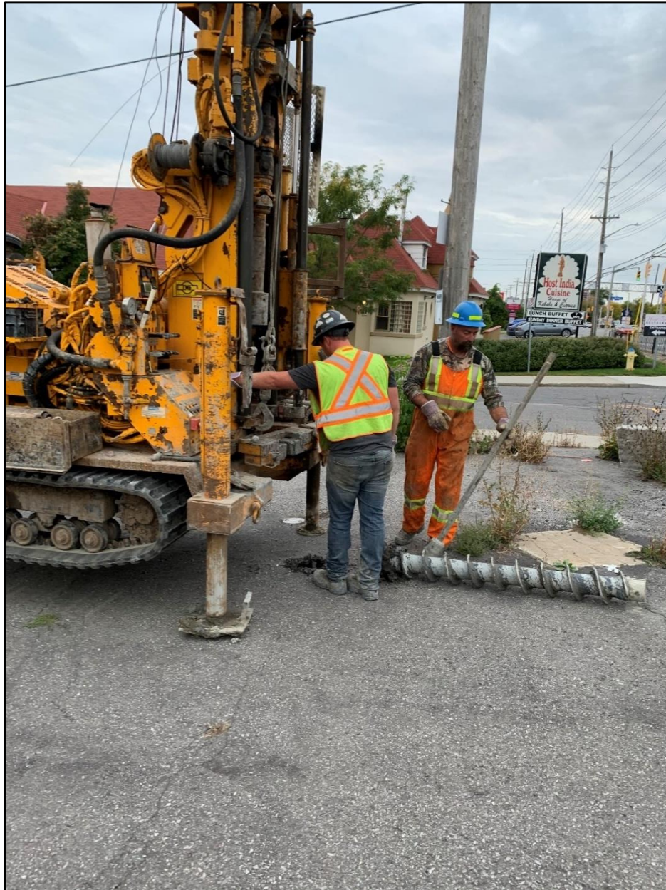
Réalisation du forage F-01
