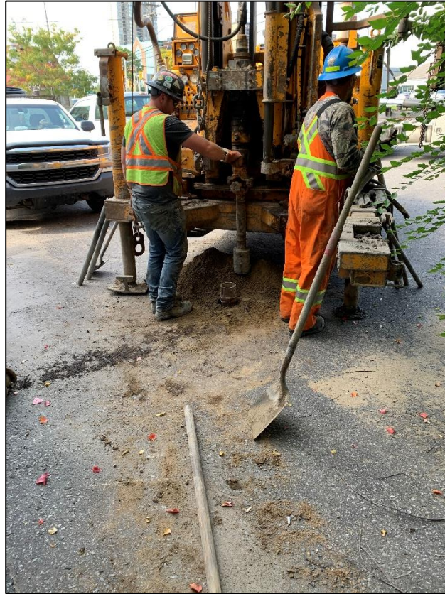
Réalisation du forage F-02
