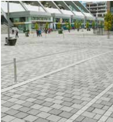
P.O.P.S. BIKE REPAIR WOONERF
