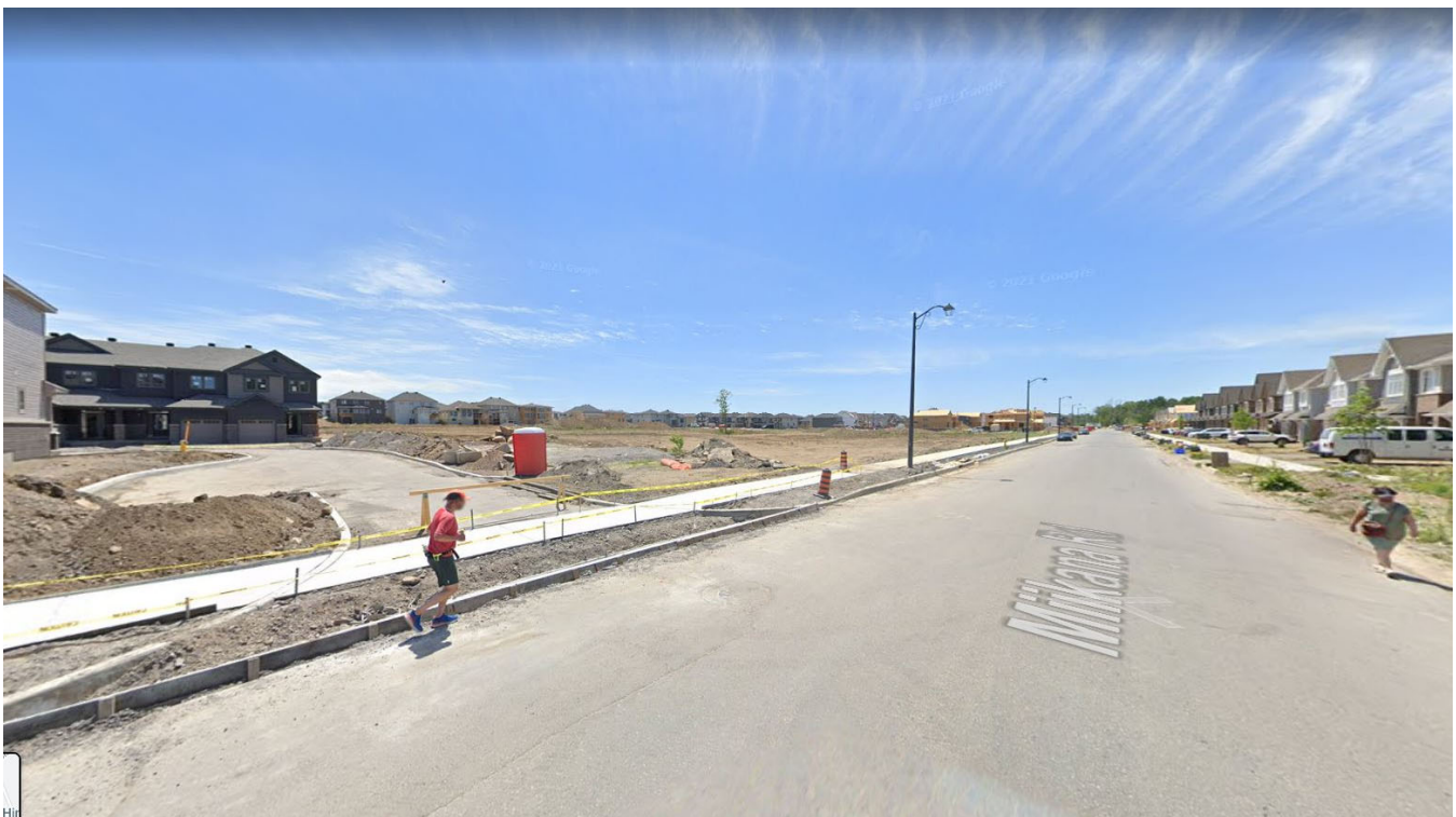
820 Miikana Road –View 01
