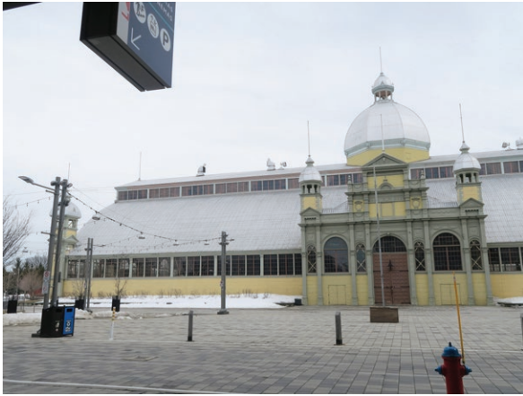
North elevation (ERA 2023)
