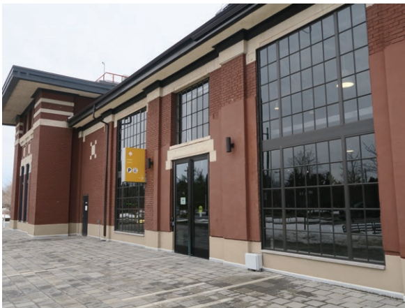
East Elevation (ERA 2023)
