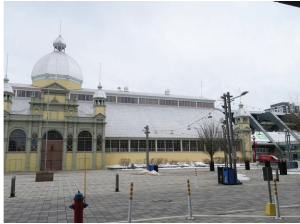
North elevation (ERA 2023)
