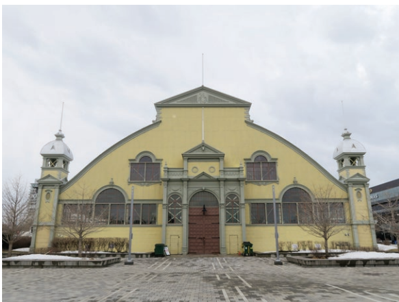
East elevation (ERA 2023)
