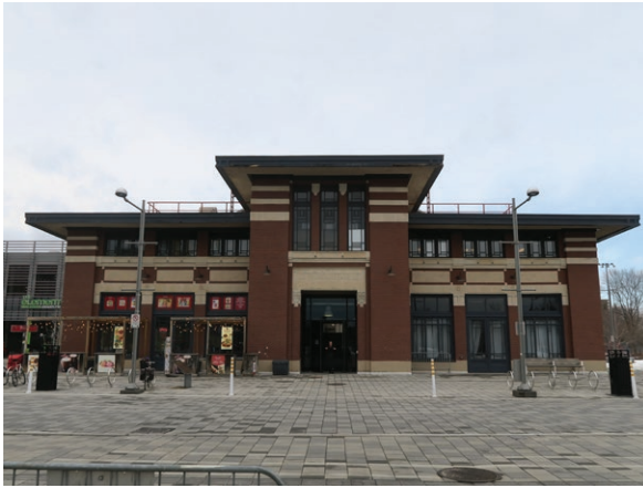
South Elevation (ERA 2023)
