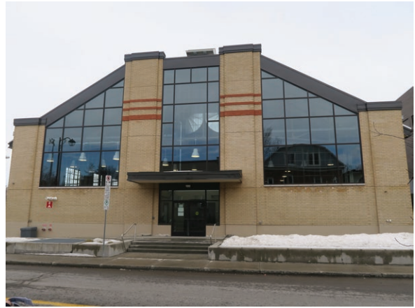
North Elevation (ERA 2023)
