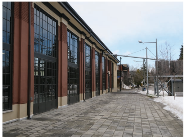
East Elevation (ERA 2023)
